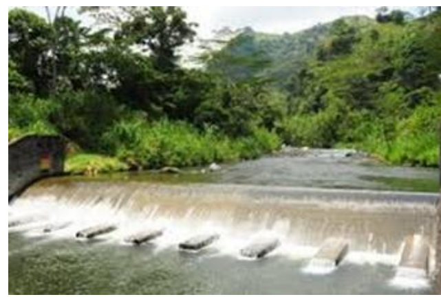
Sistema de abasto
