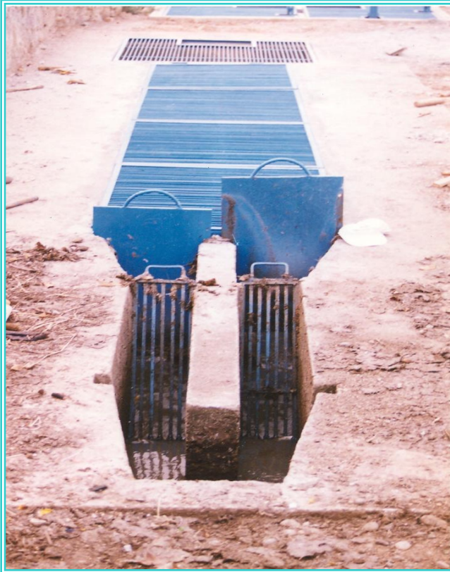
Desarenador subdiseñado, alta velocidad de flujo
